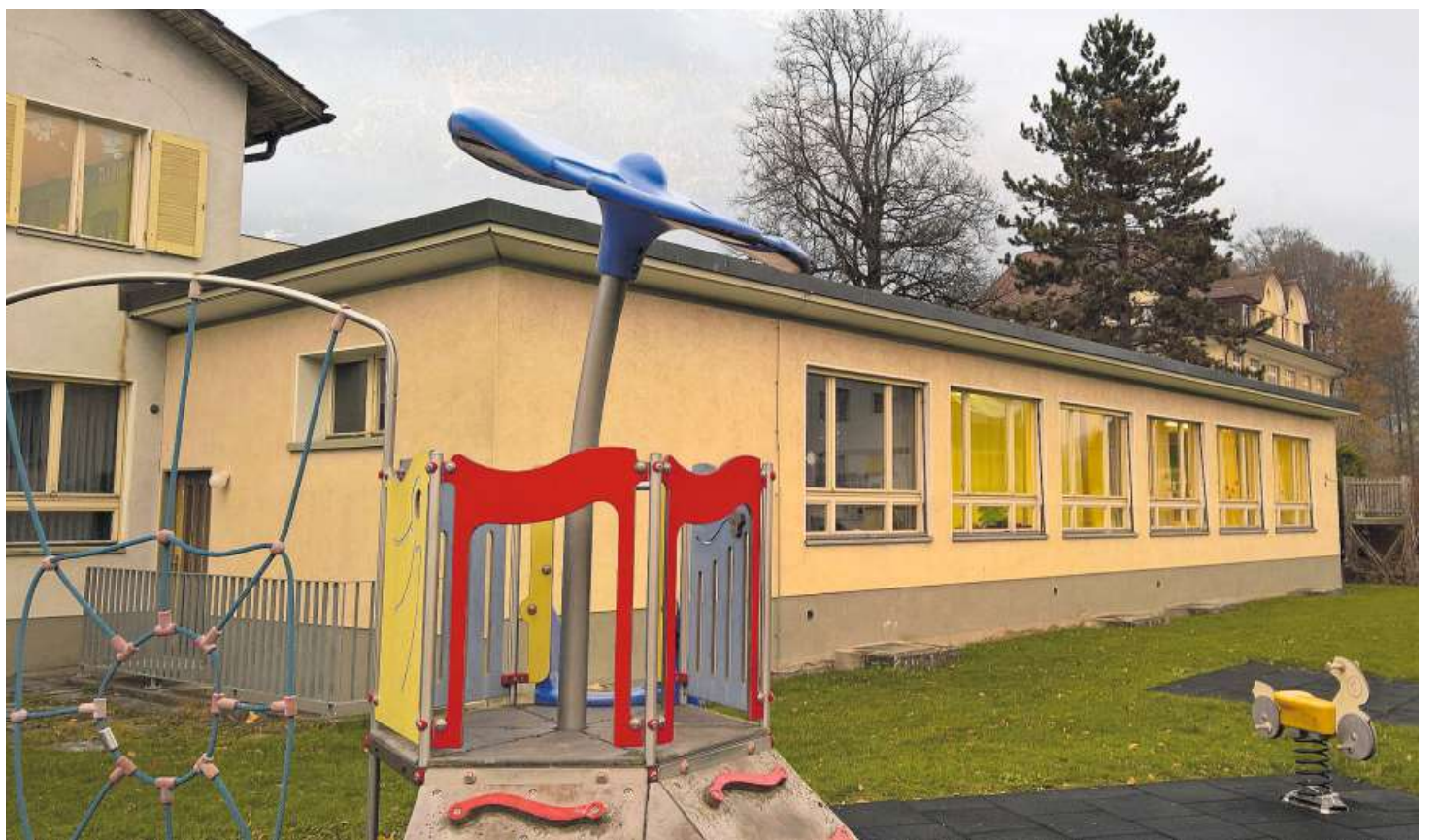
Das Schwesternhaus soll einem Neubau für mindestens sechs Kindergartenklassen weichen.
