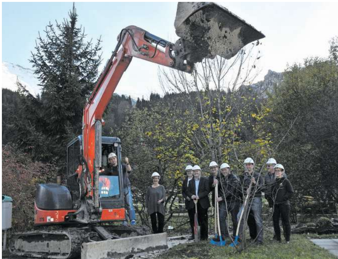
Der Bagger leitete den Bau der Alterswohnungen und die Sanierung des Erlenhauses ein - in Anwesenheit von Politik, Heimleitung und weiteren Verantwortlichen. Bild: Matthias Piazza (Engelberg, 24. Oktober 2017)
